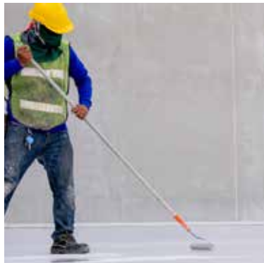
Vloer- en wandcoating
